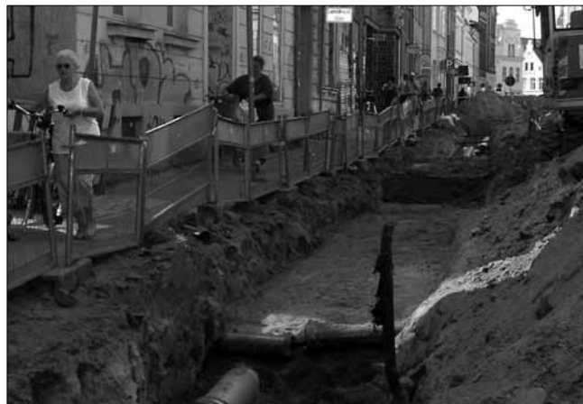
Gleviner Straße 2. BA - Verlegung der Gasleitung
