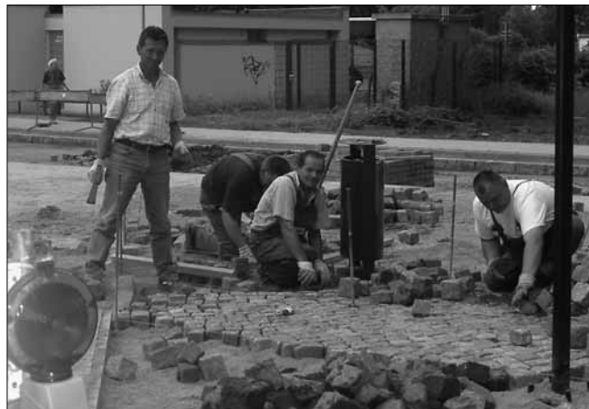
Gleviner Mauer 3. BA - Pflasterarbeiten
